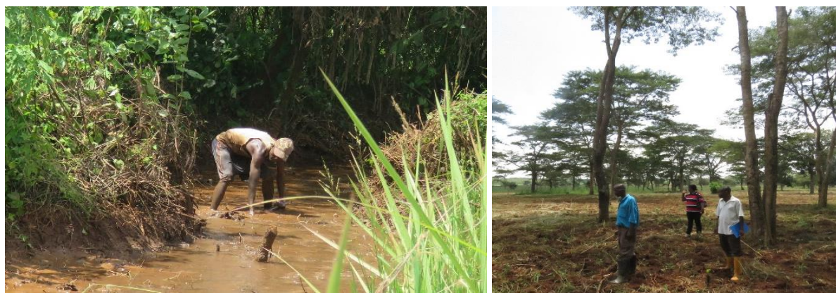
Fig.1.1.1.17 Travaux d'aménagement pour le drainage de l'eau et entretien des arbres agro-forestiers.
