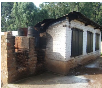
Stérilisation à la vapeur du substrat
