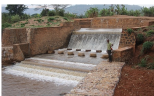
Prise d'eau dans la rivière MUSASA
